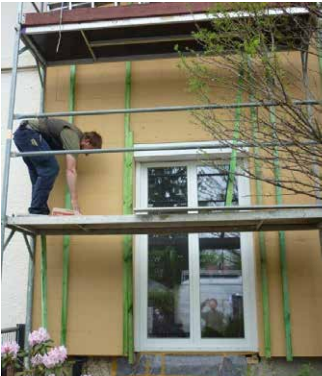
(links:) Bei einer Doppelhaushälfte in Karlsruhe aus den 1930/40er Jahren brachte das Team von „Gmp“ einen Vollwärmeschutz mit Holzfassade an. (rechts:) Das Dach wurde ausgebaut und um eine Gaube erweitert.
