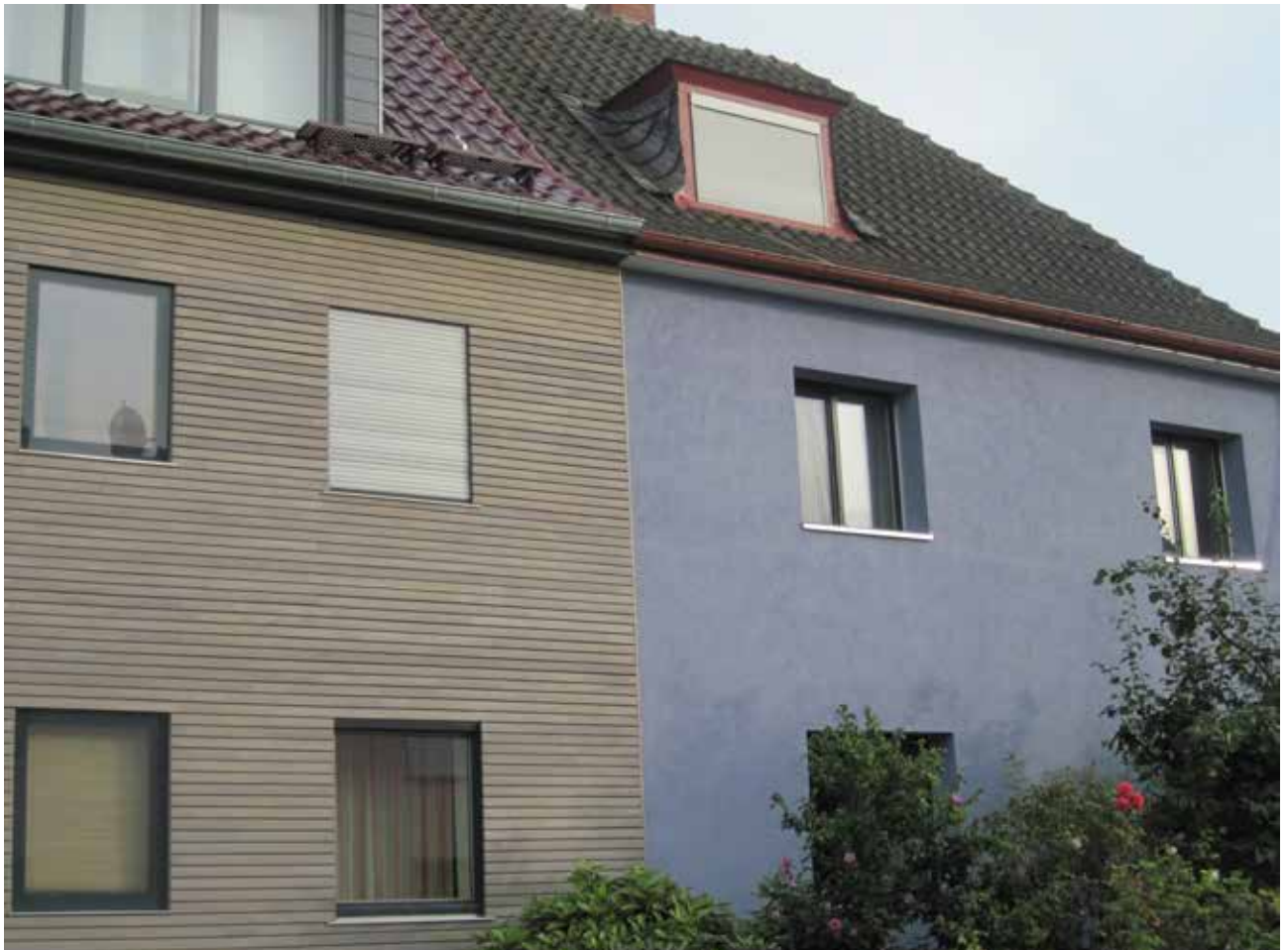
In Ludwigshafen-Nord wurde diese Fassade mit Zellulose und Holzverschalung in Kombination mit verputzten Holzfaserdämmplatten von der Firma RobinKruso gedämmt.
