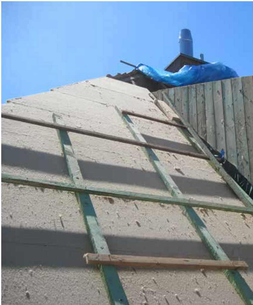
Dieses Dach in Ludwigshafen-Nord erhielt eine Zellulose-Einblasdämmung.
