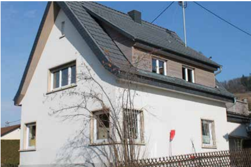
Energetisch und umweltfreundlich in einem: Einfamilienhaus in Schriesheim
