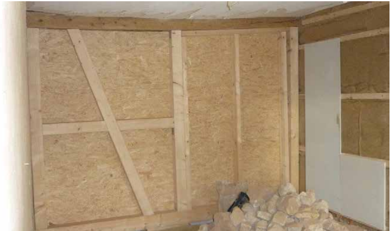
Aufgrund der guten Dämmeigenschaften setzt „Gmp“ gerne auf Zellulose und Holzweichfaserplatten.
