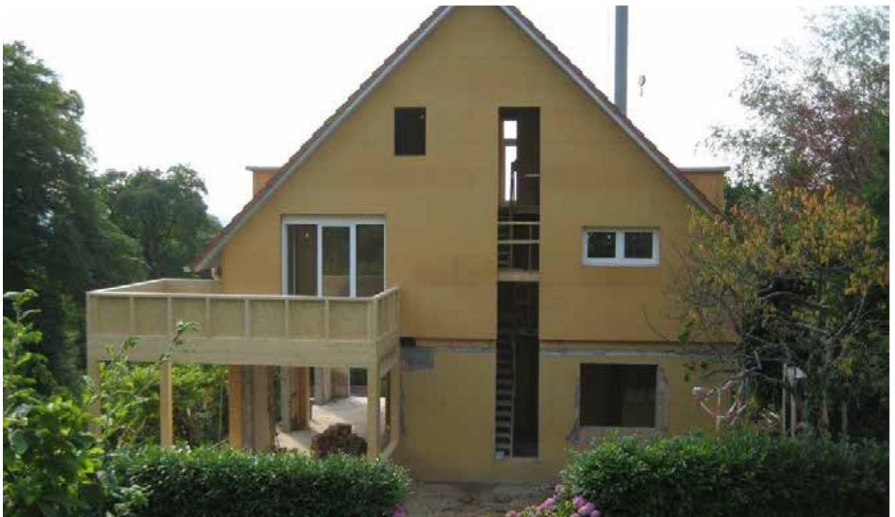
Das Haus der Familie Brüherr in Heidelberg wird komplett entkernt, umgebaut und ökologisch gedämmt.
