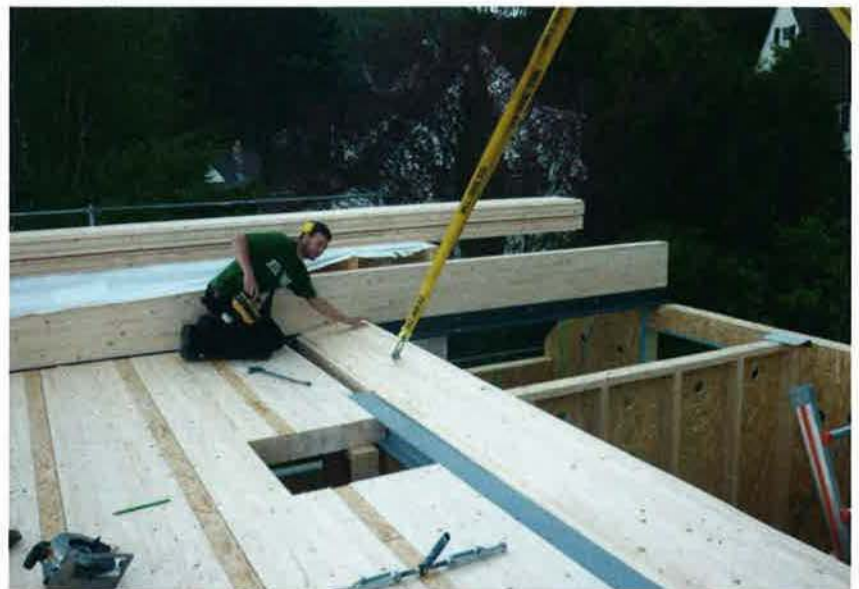
Das Haus erhielt eine neue Massivholzdecke.
