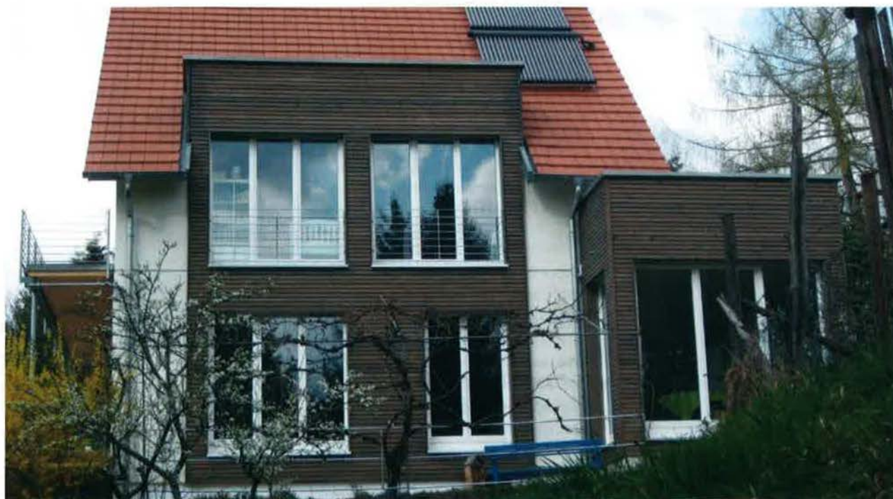
Das Ziegelmauerwerk wurde zum Teil mit Lärchenholz verkleidet und zum Schutz vor Witterungseinflüssen mit einer vorvergrauten Lasur behandelt. Der Anbau samt Wintergarten war Teil der Komplettsanierung.
