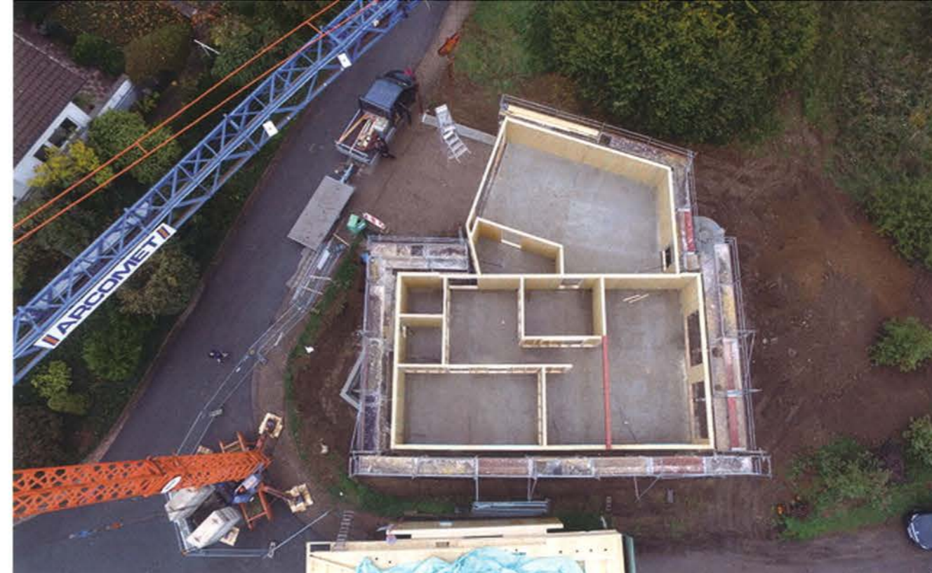
Drohnen-Perspektive auf die Holzständer-Bauweise.
