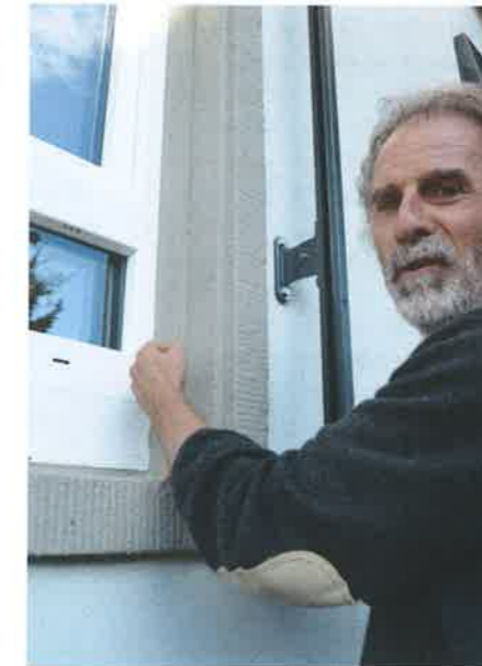
Mit Einbau von dreifachverglasten Fenstern musste die Laibung ergänzt werden – der Laie sieht dies nicht.
